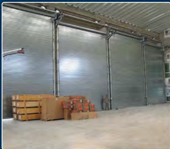
Rideaux en lames double paroi - L = 7,2 m H = 10 m
