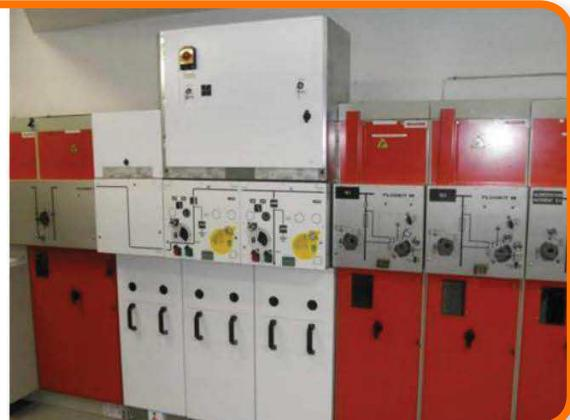
**Remplacement des cellules normal / secours**
