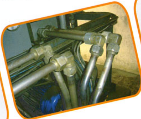
Réalisation du circuit hydraulique HP
