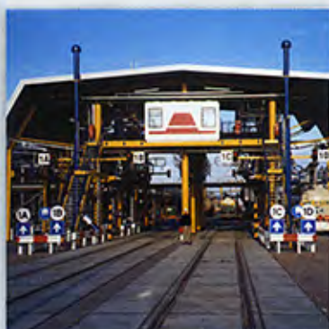
Pont-basculle Rail mixte Rail-Route
