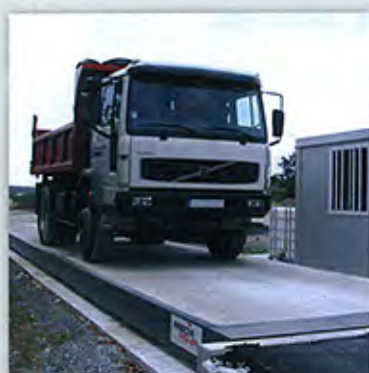
TSE : Pont-basculle béton, coulé sur site
