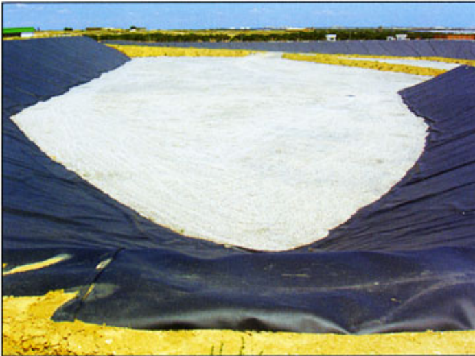
Décharge contrôlée de Monastire (Tunisie)
