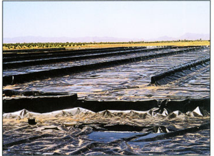
Station d'Épuration Laatouia (Maroc)
